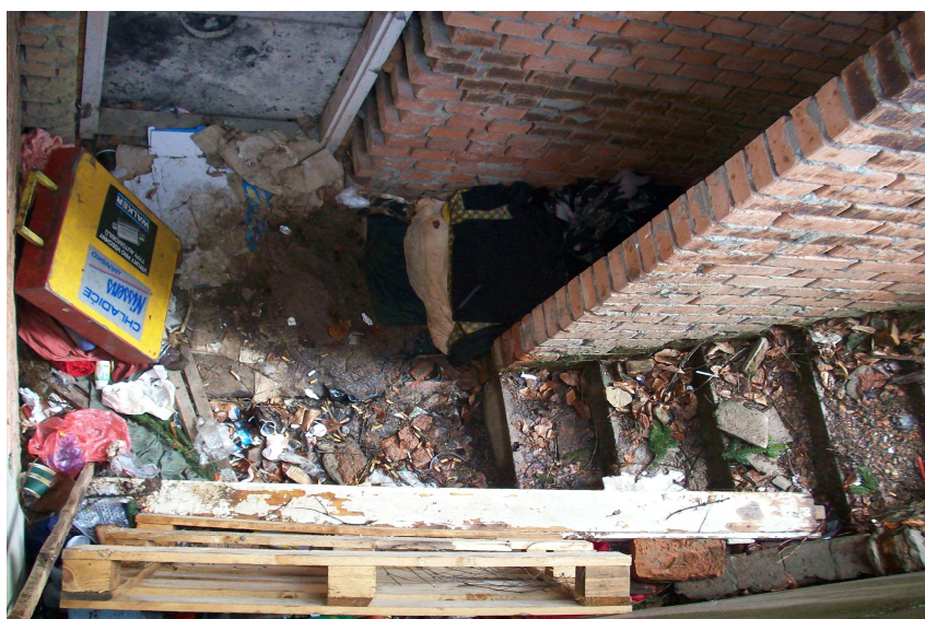
Obrázek 8. Venkovní přístřešek u schodiště
