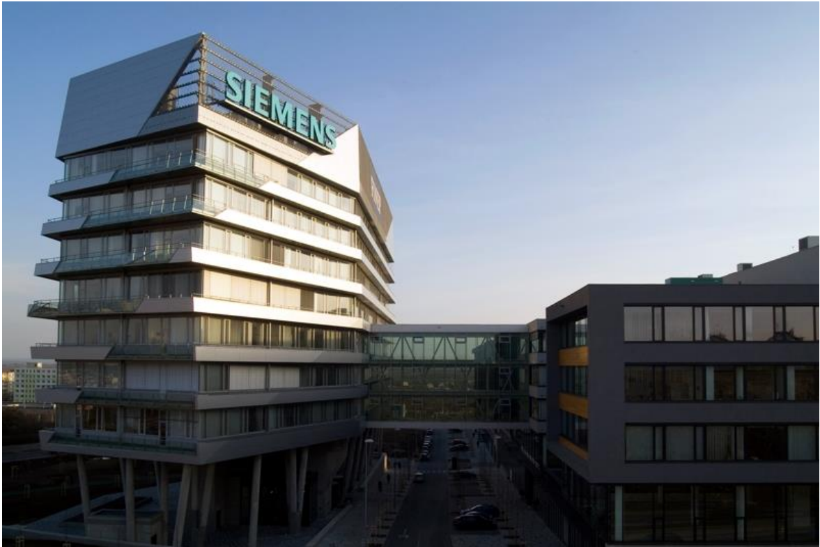
Obrázek 9 Sídlo společnosti Siemens s.r.o. (interní materiály)
