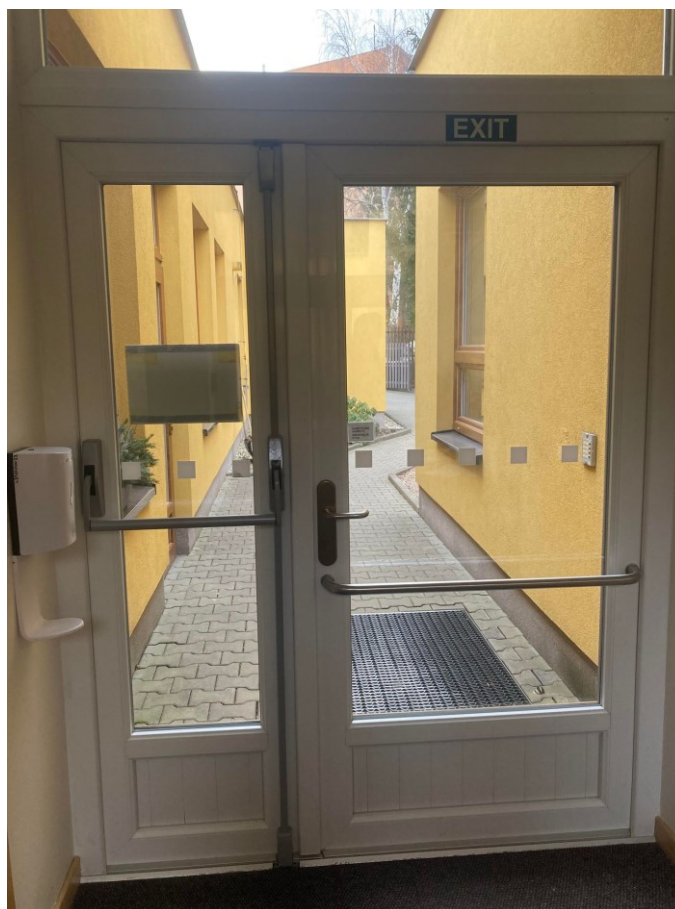
Obrázek 2 Hlavní vchod (vlastní fotografie)
