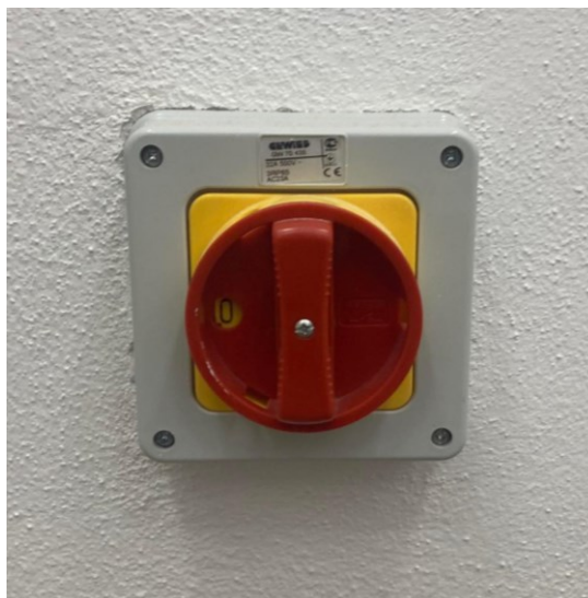
Obrázek 7 Vačkový vypínač proudu (vlastní fotografie)
