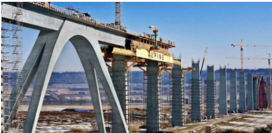
Obrázek 9: Železniční most u Karsdorfu (interní dokumentace)
