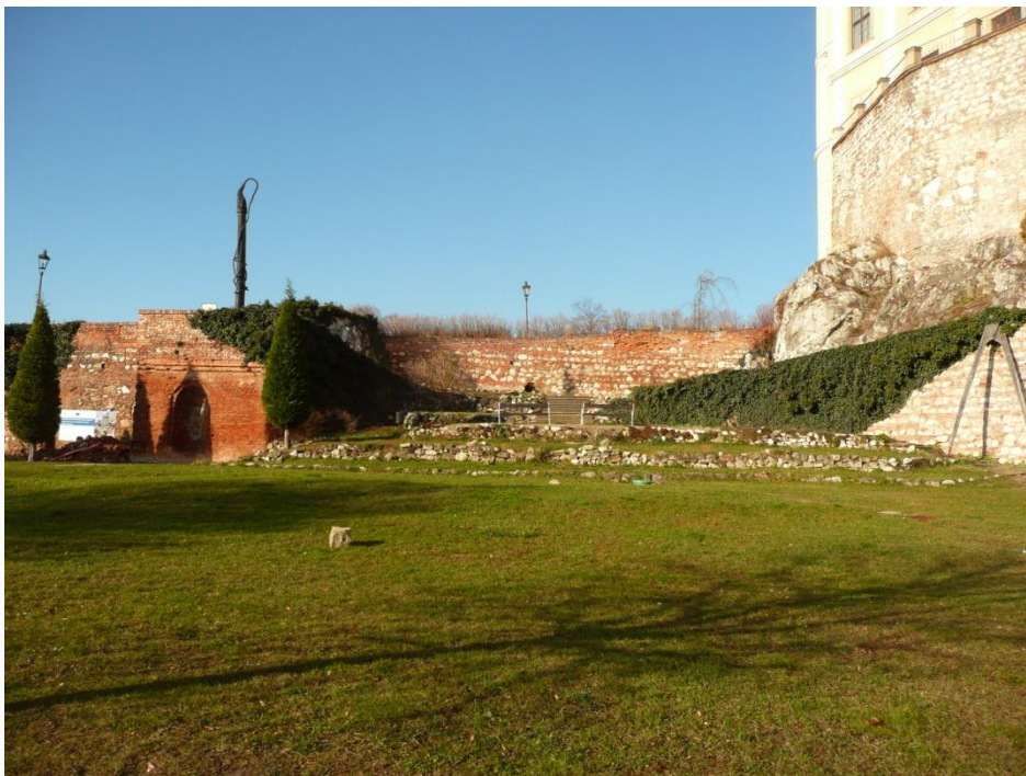
Obr. 18. Jižní zahradní amfiteátr - pohled od východu
