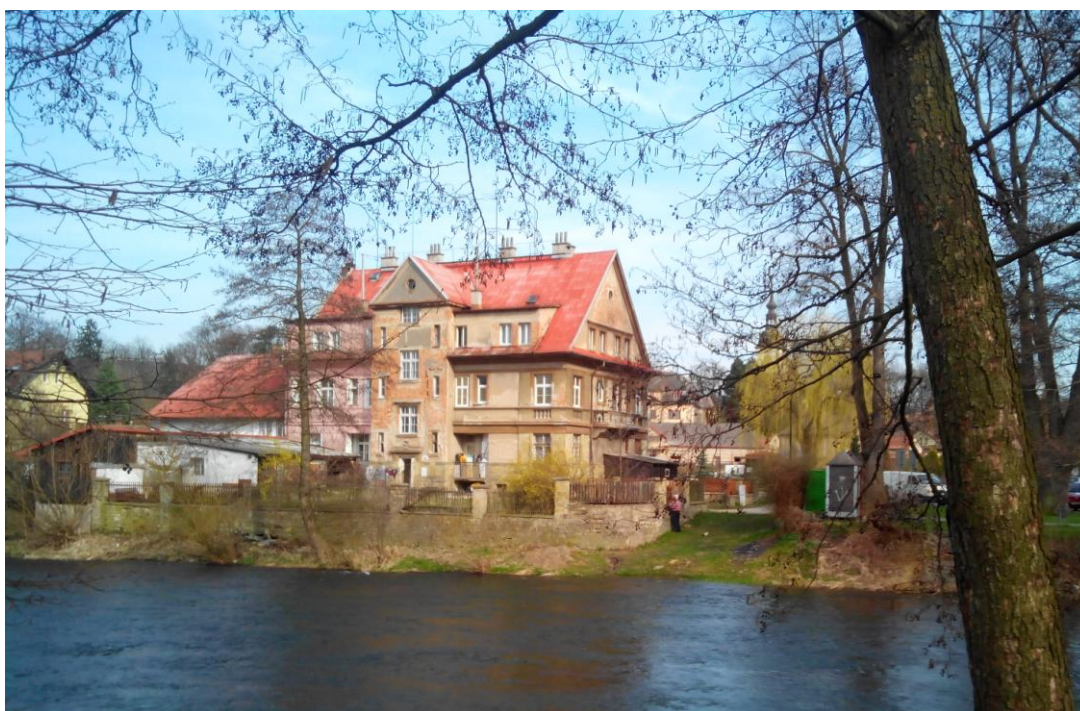
Obr. 32. Současný stav objektu
