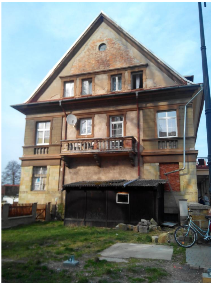
Obr. 29. Současný stav jihozápadní fasády
