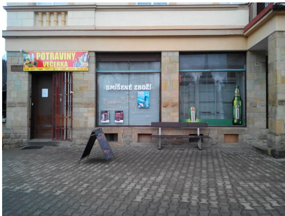
Obr. 27 a 28. Foto stávajícího stavu průčelní fasády
