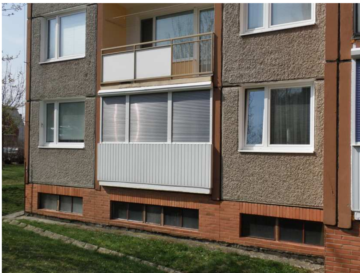
Obrázek 18 - Zabezpečení lodžie pomocí rolet (Zlín – JS)[9]
