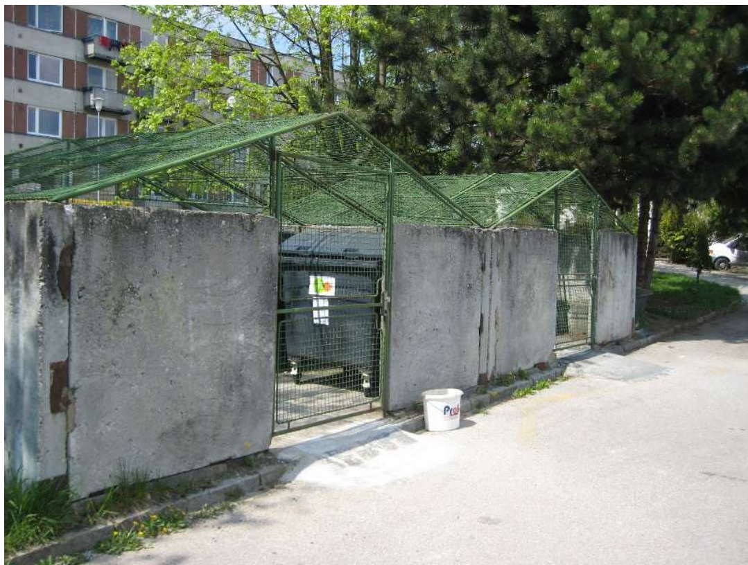
Obrázek 16 - Kontejnerové stání (Brno-Bystrc)[9]
