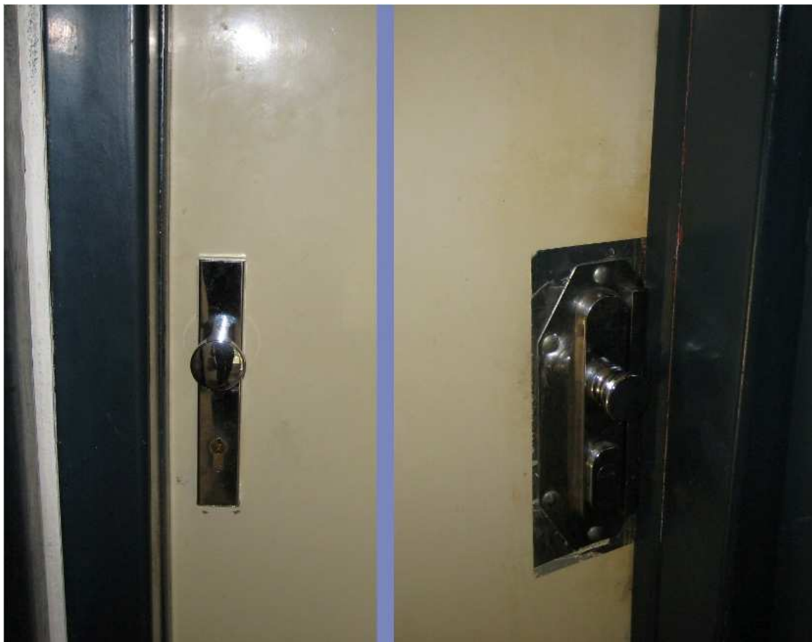
Obrázek 4 - Plechové dveřní kování (vlevo), bezpečnostní kování (vpravo)[15]
