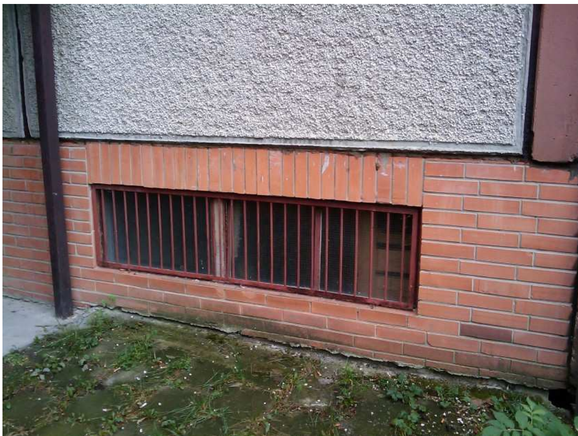
Obrázek 19 - Zabezpečení sklepních oken mřížemi (Zlín - JS)[9]
