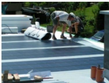
Obrázek 19: Instalace fotovoltaické folie [18]
