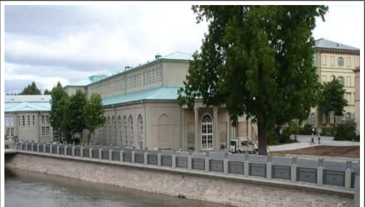
Obrázek 1: Příklad protipovodňové ochrany mobilní. 31
