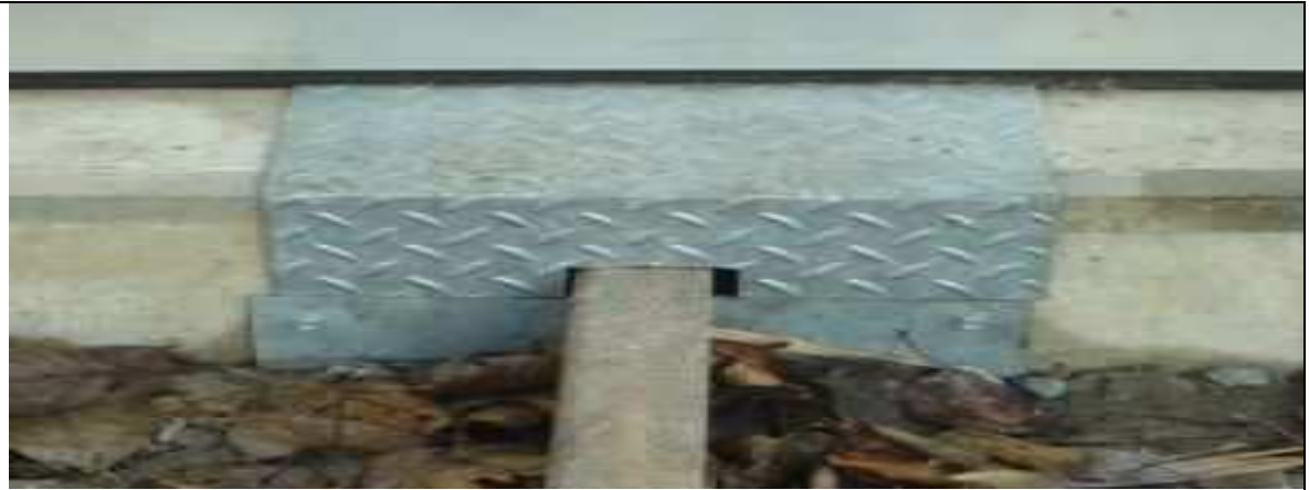
Obrázek 16: Zvláštní těsnění pro železniční koleje. 46
