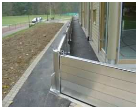
Obrázek 12: Mobilní zábrany pro ochranu celé budovy.
