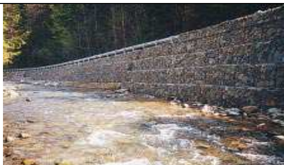
Obrázek 19: Ukázka Gabionové zdi v terénu.
