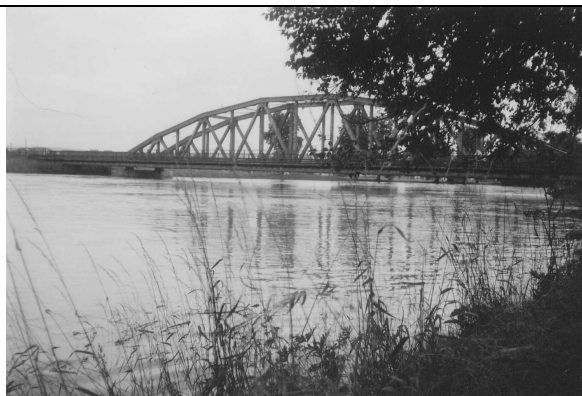
Obrázek 21: Pohled na železniční most před vylitím Moravy z koryta.
