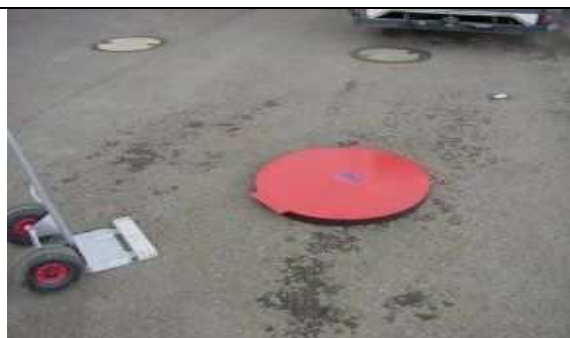
Obrázek 18: Kanálové zakrytí kruhové, samonosné a sjízdné . 47
